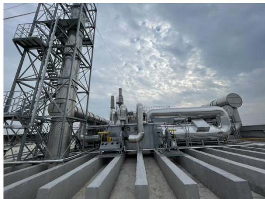
过滤+沸石转轮+TO 系统+DA003 排气筒
