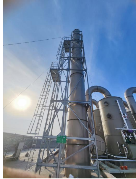
碱液喷淋吸收塔+DA002 排气筒
