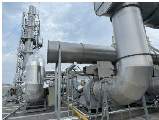
过滤+沸石转轮+TO 系统+DA003 排气筒
